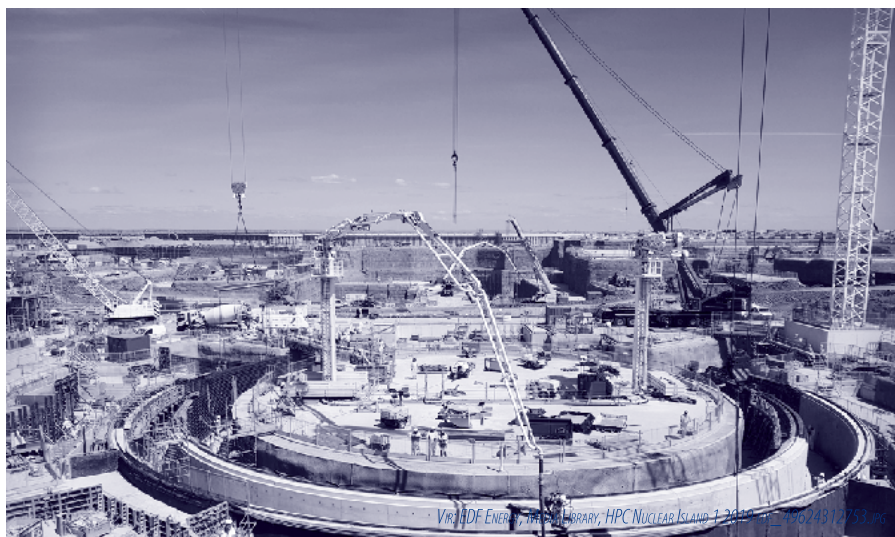
Gradbišče jedrske elektrarne Hinkley Point C, januar 2019.
